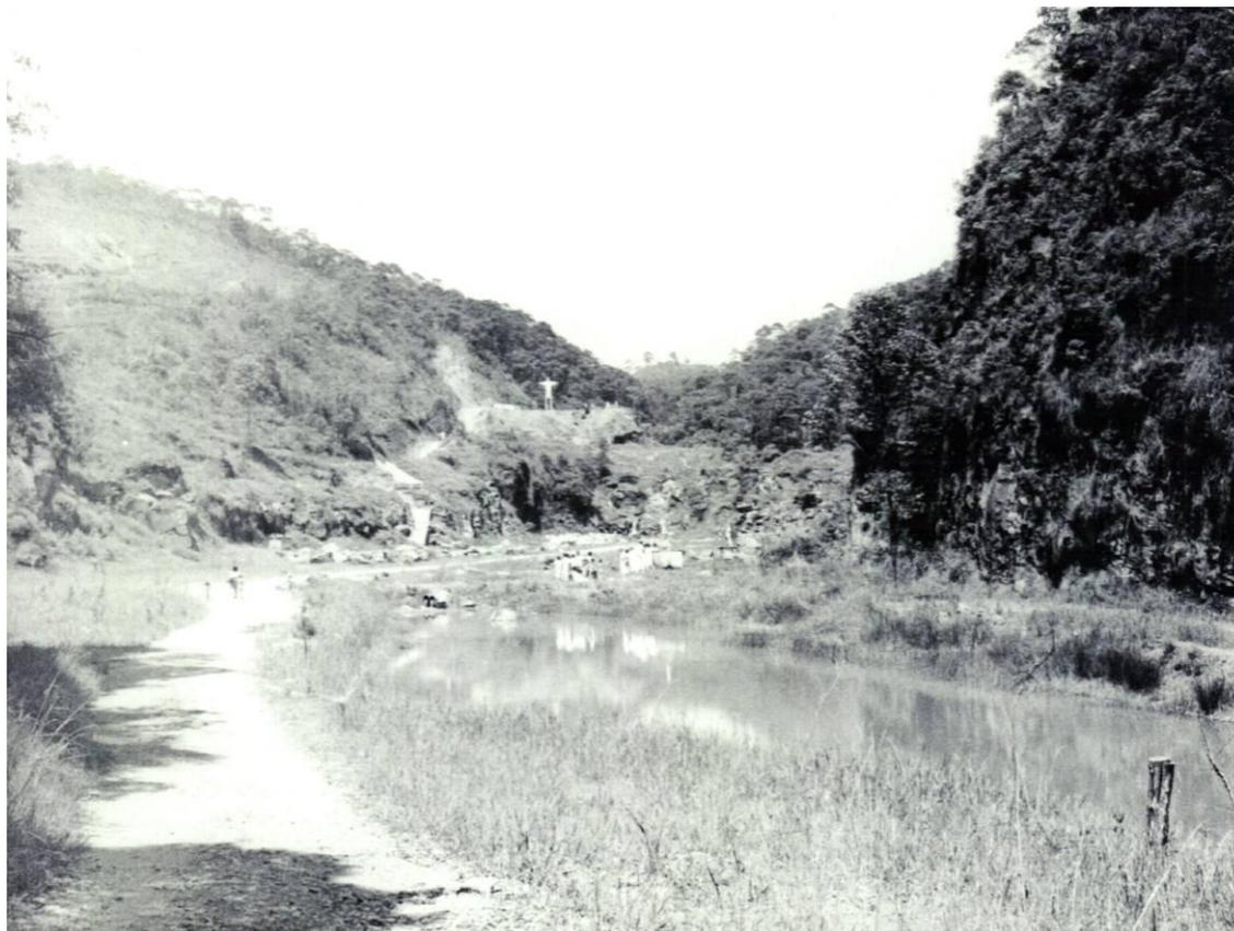
Foto dos anos 1970. Área degradada pela atividade mineraria com retirada de cobertura vegetal nativa, cortes no terreno que provocaram a instabilização de encostas, exposição de solo, acúmulo de rejeito da lavra e alteração na drenagem local com formação de lagos na base da cava. Foto cedida pelo Santuário Nacional de Umbanda.
